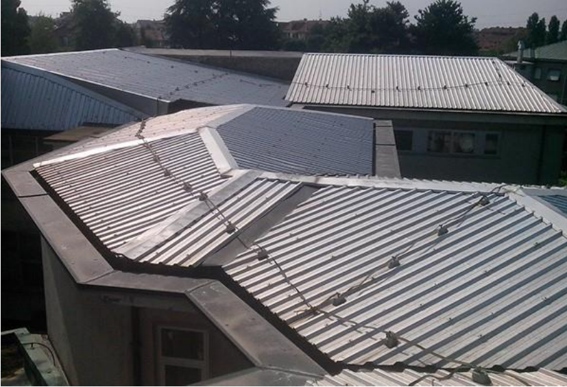
Foto 2 – vista generale delle sovracoperture
