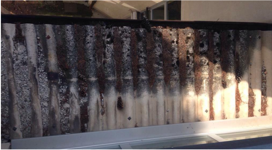
Foto 1 – copertura in eternit tettoia lato segreteria
