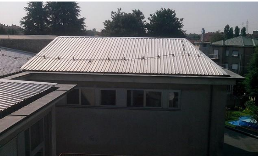
Foto 4 – vista particolare di una sovracopertura
