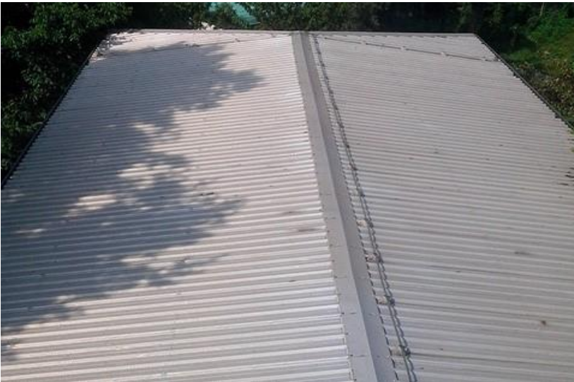
Foto 3 – vista da vicino di una sovracopertura
