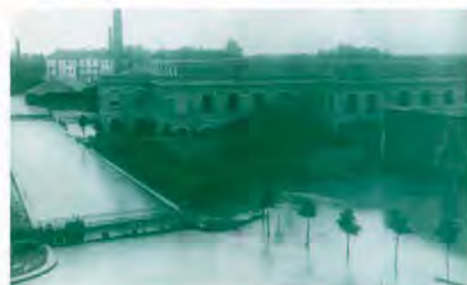
Cotonificio Cantoni durante l'alluvione del 1917
